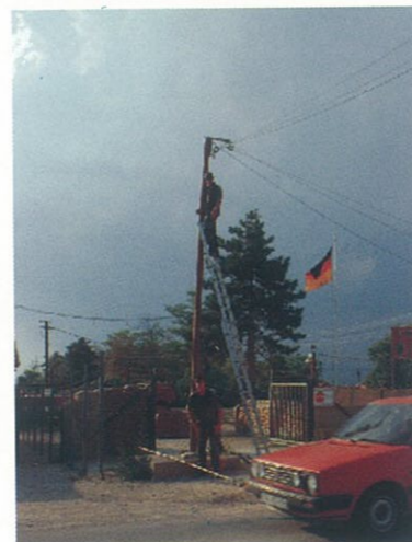
Beim Kabelbau im Lager NORD
