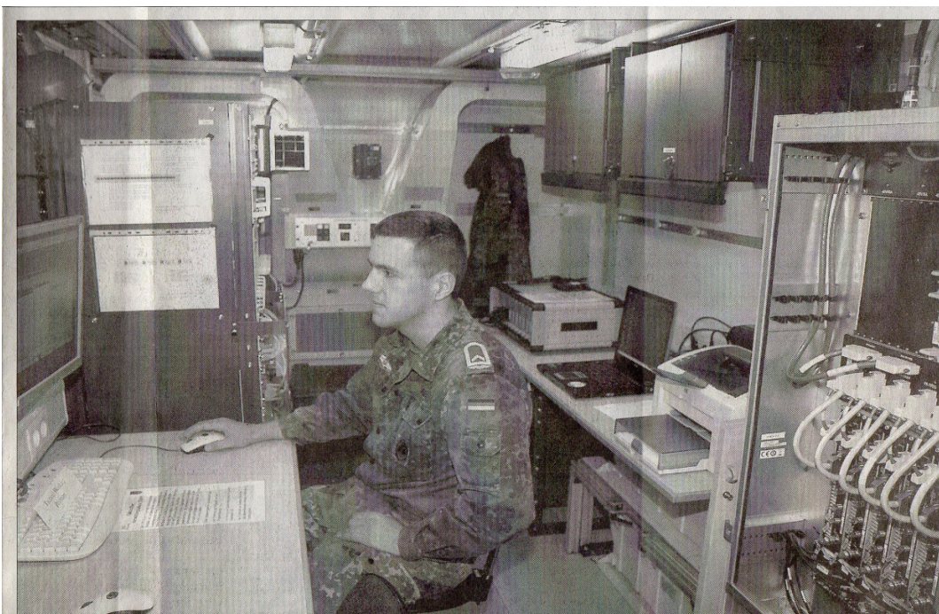
Das Herzstück des Tetrapol-Systems: Ein solcher Container nennt sich in der Bundeswehrsprache „Trupp“. In dieser Basisstation können Funkkreise festgelegt werden, das heißt: Dort wird entschieden, wer mit wem sprechen darf und wer berechtigt ist was zu hören. Hier könnten auch herkömmliche Funkkreise eingespeist werden. ■ Fotos: Willi Willig
